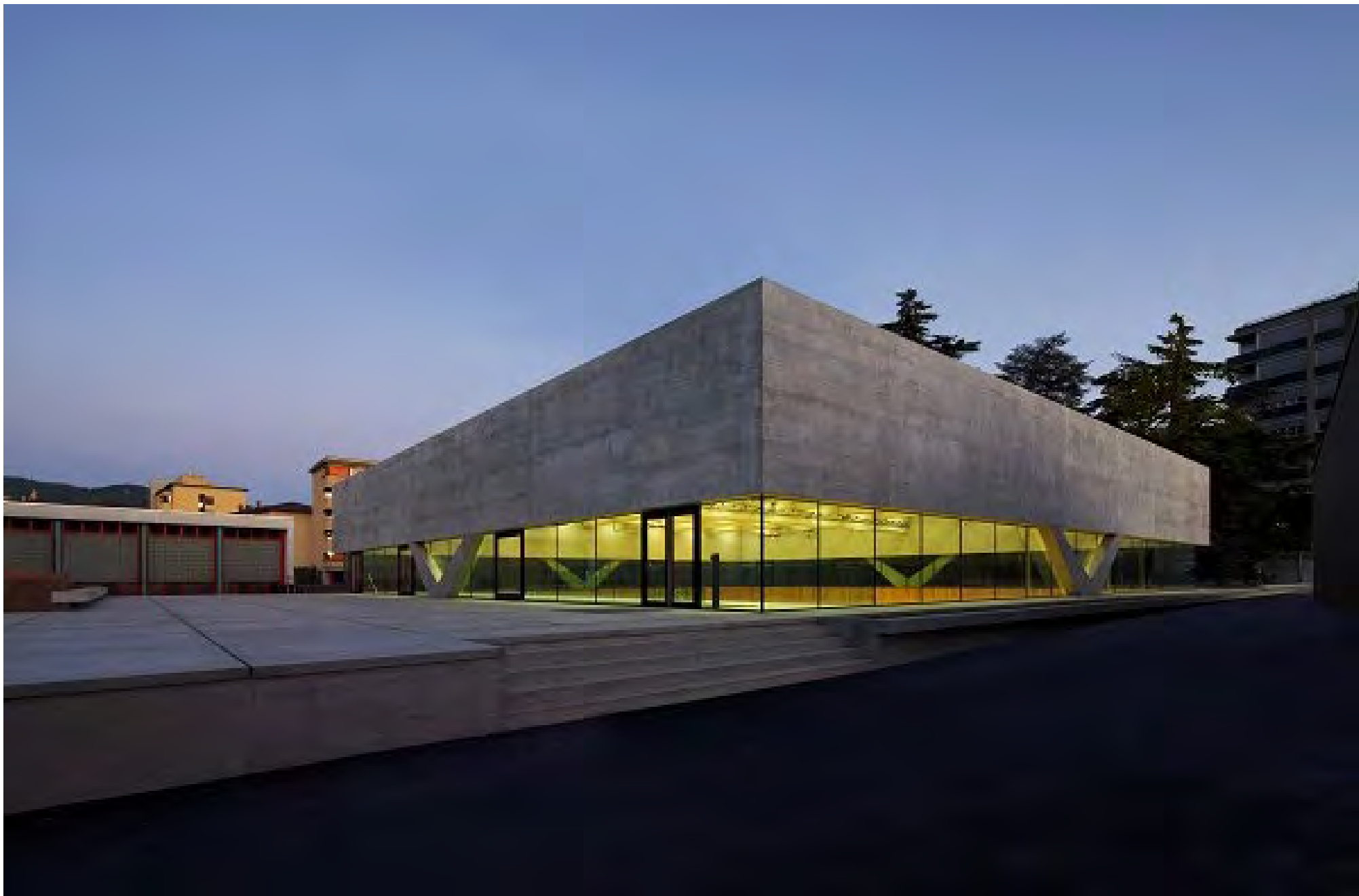
Doppia palestra, Chiasso, 2007-2010, Arch.: Baserga Mozzetti Architetti, Ing.: Ingegneri Pedrazzini Guidotti
