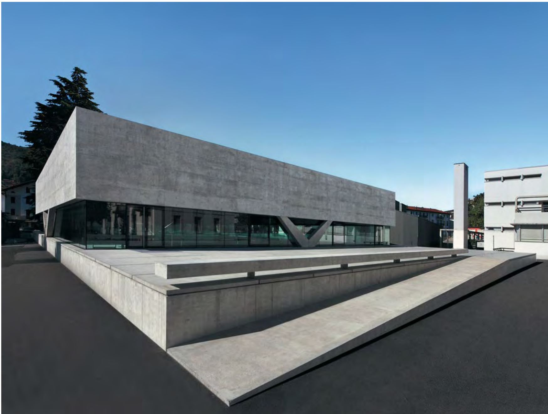
Doppia palestra, Chiasso, 2007-2010, Arch.: Baserga Mozzetti Architetti, Ing.: Ingegneri Pedrazzini Guidotti
