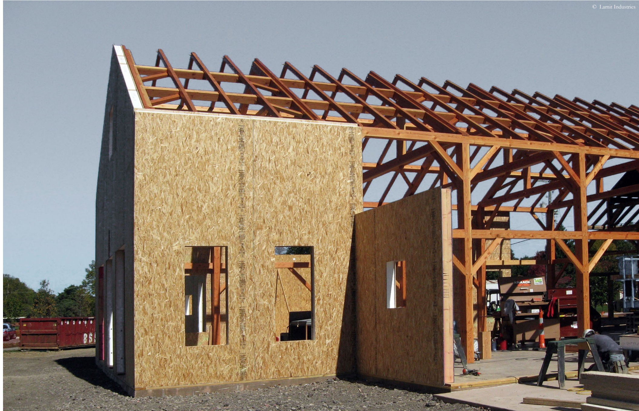
OSB-Platten als Aussteifungselemente
