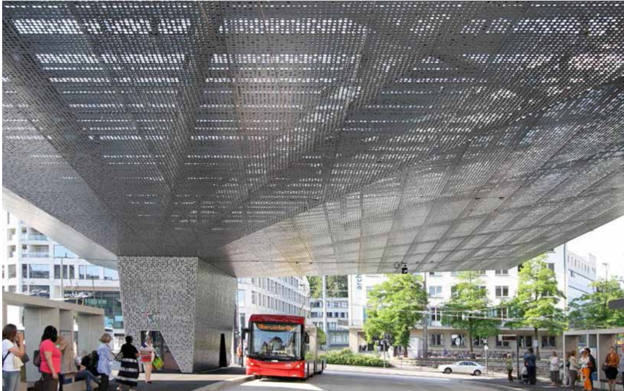
Stutz + Bolt + Partner, Joseph Schwartz; Überdachung Bahnhofplatz Winterthur, 2013
