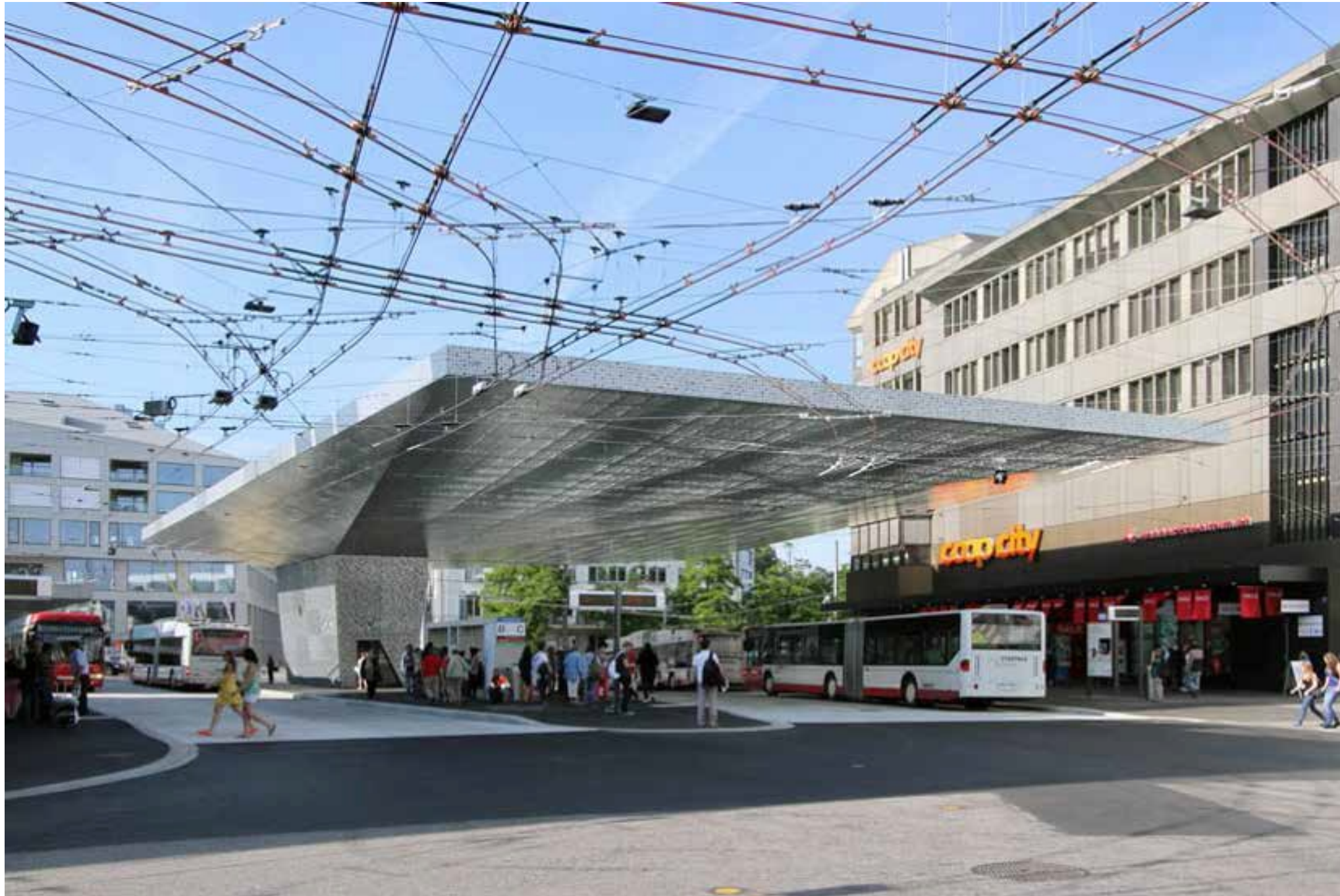
Stutz + Bolt + Partner, Joseph Schwartz; Überdachung Bahnhofplatz Winterthur, 2013
