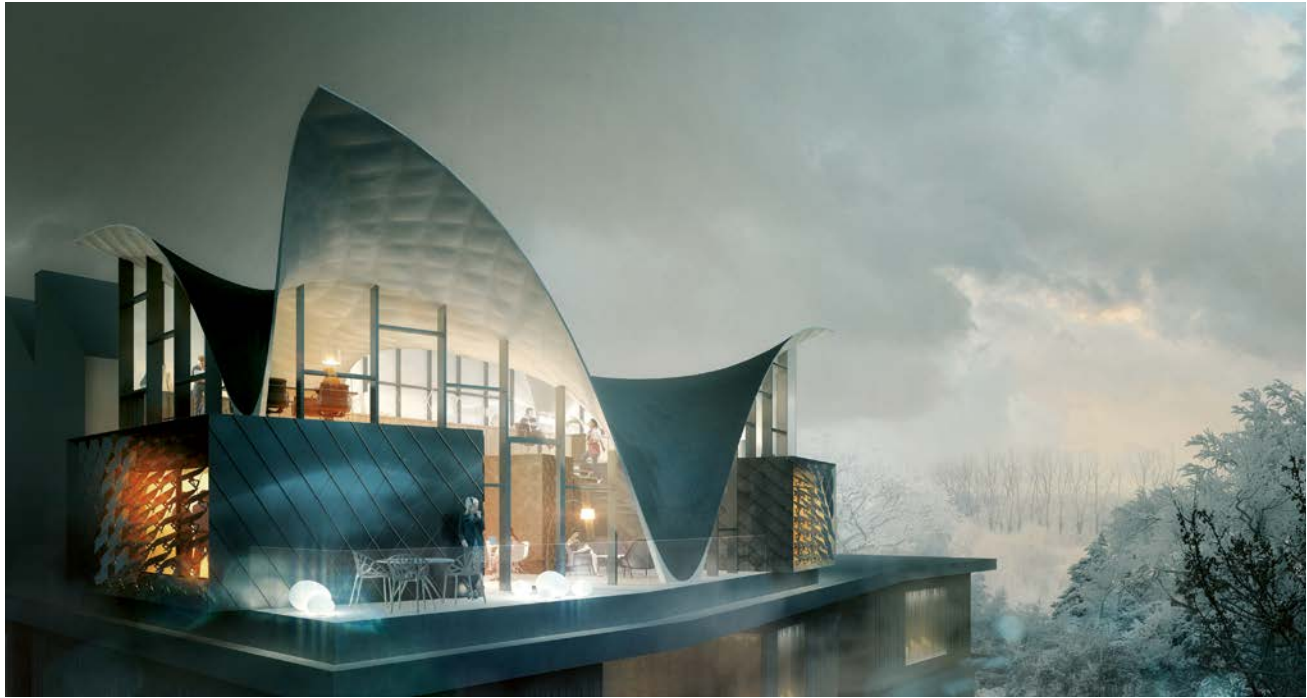
Visualisierung der Unit HiLo mit ultradünner Dachschaale, adaptiven Solarfassaden und leichten Bodenplatten im Zwischengeschoss.
