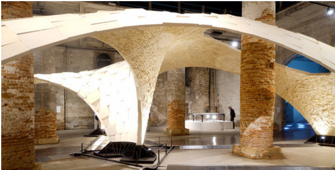
Die 399 Steine sind nur durch Druck miteinander verbunden.
