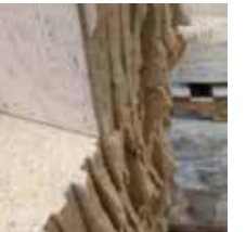
Nahaufnahme des Gewölbesteins des Armadillo Vault, dessen kammartige Steinfinnen nachträglich von Hand abgeschlagen wurden.
