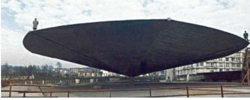
Figure 9. 40-m-span umbrella in Pola de Siero, Spain. Ildefonso Sánchez del Río, 1971–72 (Manterola 2011).
