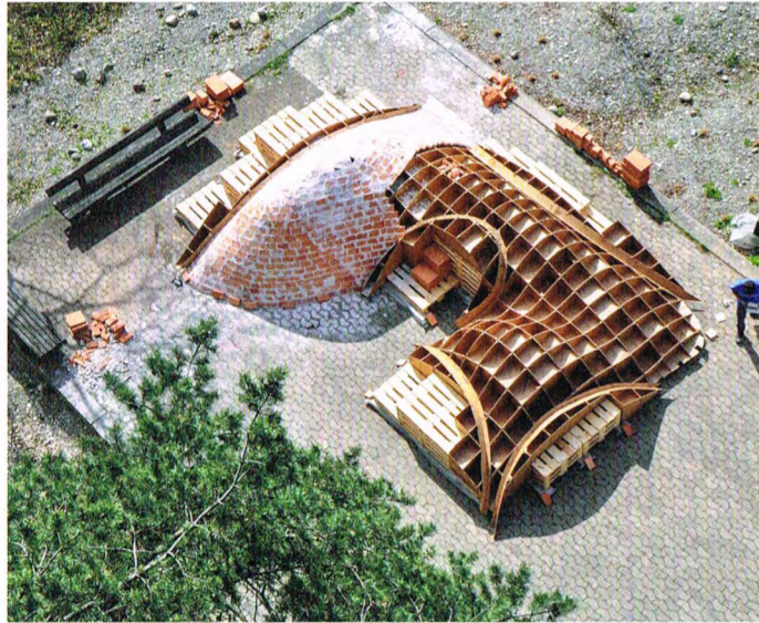
Dünne Ziegel werden direkt auf das Lehrgerüst gemauert Thin-tile vault under construction over centering
